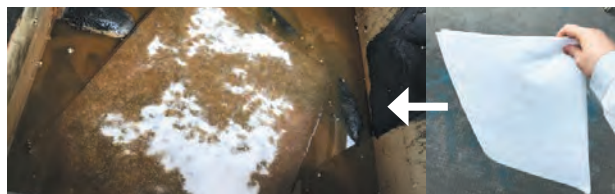
沈澱池へ吸収綿を入れる
