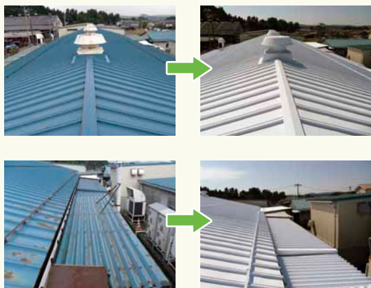
腐食により老朽化した工場の一部屋根を断熱塗装に切り替えました
