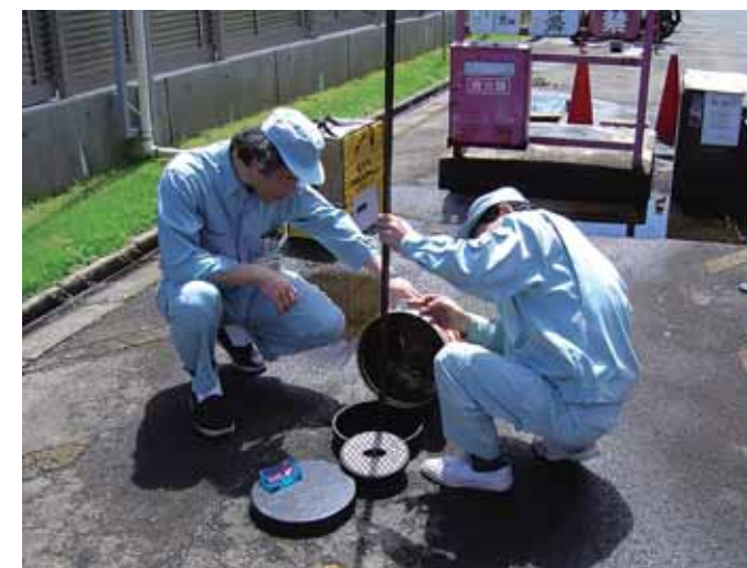
地下タンクの点検。重油が漏れていないか定期的にチェックしている
